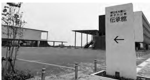
▲津波跡の更地に建てられた伝承館。1階にはレストランやフードコートが併設されている。
