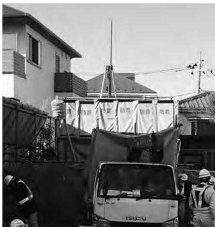
ボーリング調査を行なっている現場。この下で3つ目の空洞が見つかった。調査中の騒音もひどい。
